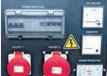
Analoge Anzeigen und Steckdosenleiste
